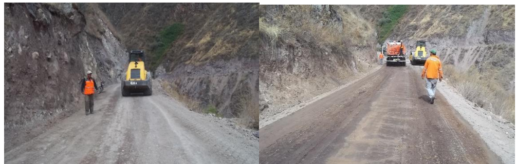
COMPACTACION DE PLATAFORMA
