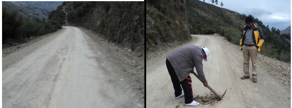
MANTENIMIENTO PERIODICO CARRETERA : CHONTA – ABRA – HUAYRACCASA CHIPCHILLAY HUACHOCOLPA
