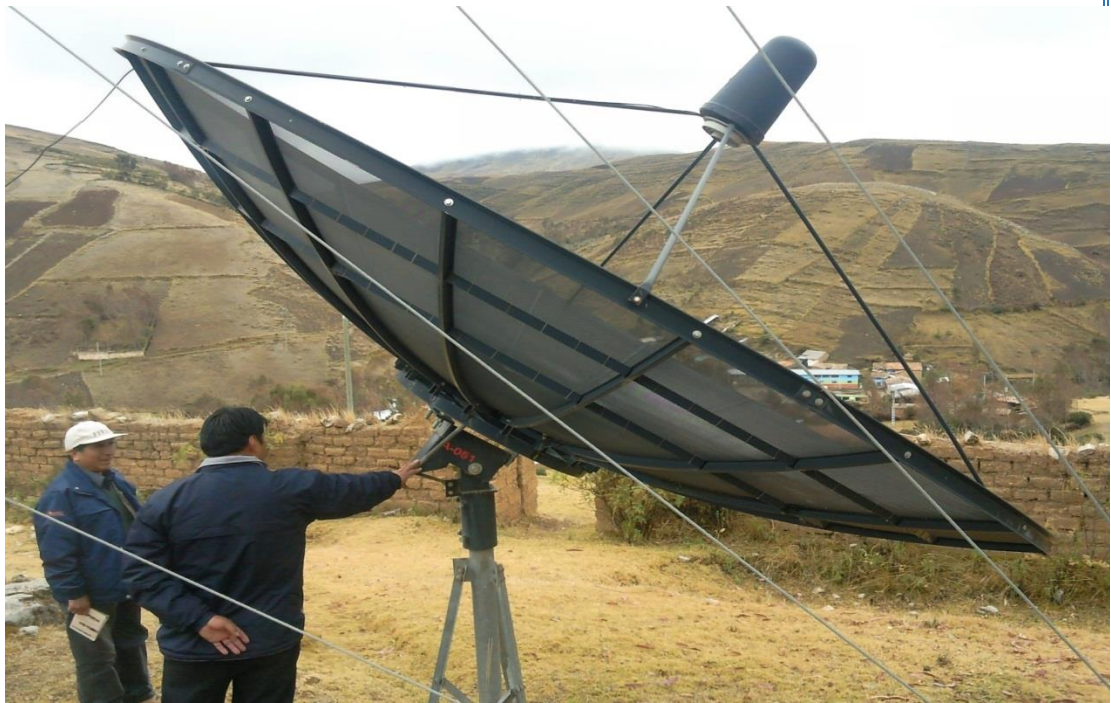
REALIZANDO TRABAJOS DE POSICIONAMIENTO DEL REFLECTOR PARABOLICO
