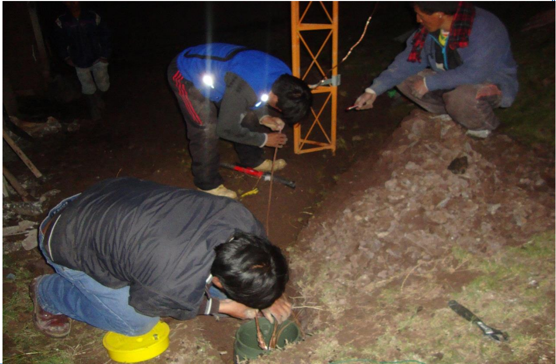
REALIZANDO LA INSTALACION DE SISTEMAS DE POZO A TIERRA EN LA LOCALIDAD DE PUCACRUZ
