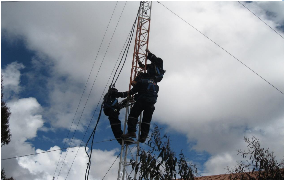
REALIZANDO TRABAJOS DE MANTENIMIENTO DE LAS ANTENAS DE RADIO Y TELEVISION
