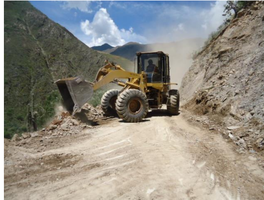
LIMPIEZA DE DESLIZAMIENTO DE TIERRA
