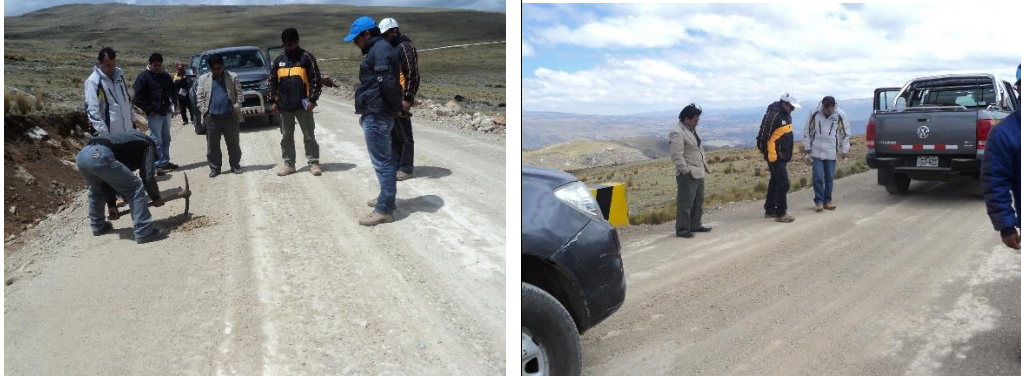
ENTREGA Y RECEPCION DE LA OBRA "REHABILITACION CARRETERA CUNYACC – PUCAPAMPA - CHECCOCRUZ
