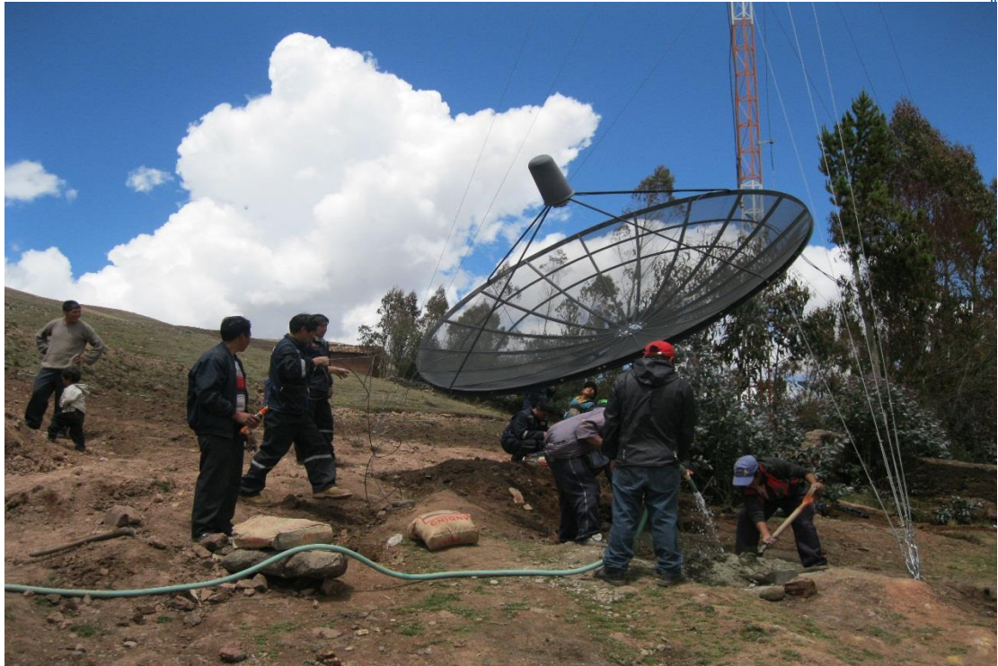
REALIZANDO TRABAJOS DE MANTENIMIENTO EN LAS ESTACIONES DEL PROYECTO “CPACC”.
