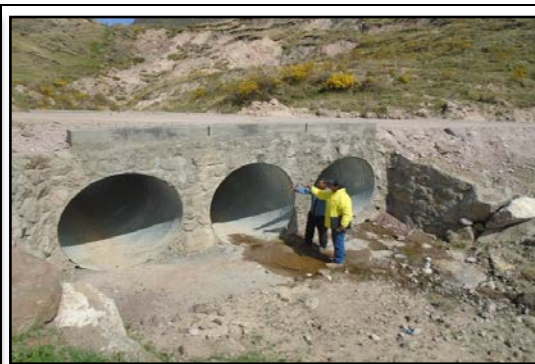
REPARACIÓN DE ALCANTARILLAS
