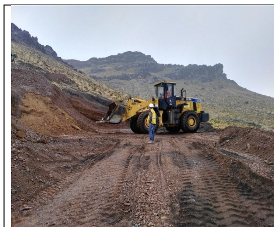
ACOPIA DE MATERIAL APROPIADO PARA LASTRADO
