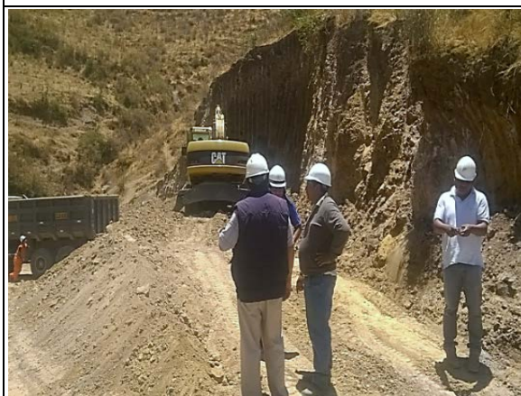
ALMACENAMIENTO DE MATERIAL PARA LASTRADO DE PLATAFORMA
