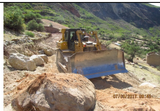
APERTURA DE CARRETERA
