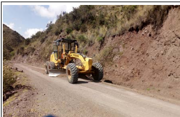
DESENCALAMINADO DE LA PLATAFORMA
