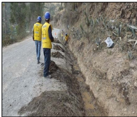
LIMPIEZA DE CUNETAS
