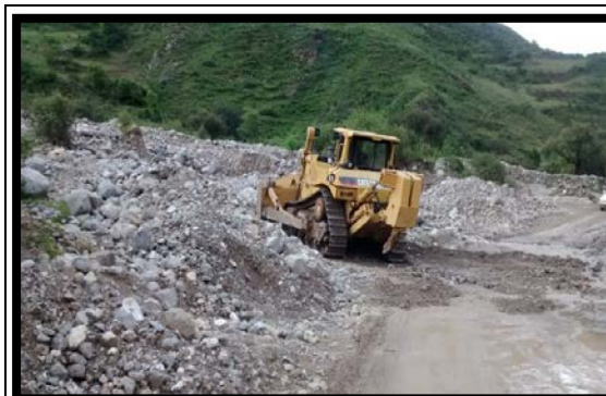
LIMPIEZA DE CAUCE DE QUEBRADA
