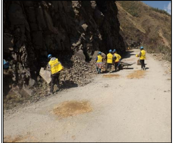
LIMPIEZA DE DERRUMBES MENORES
