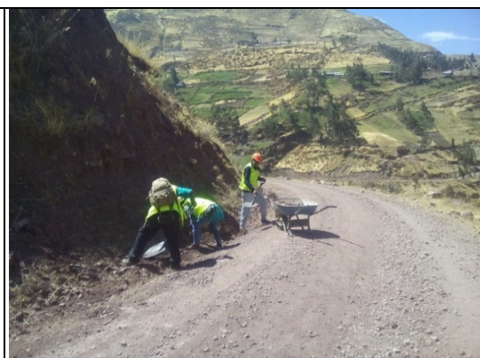
LIMPIEZA DE CUNETAS
