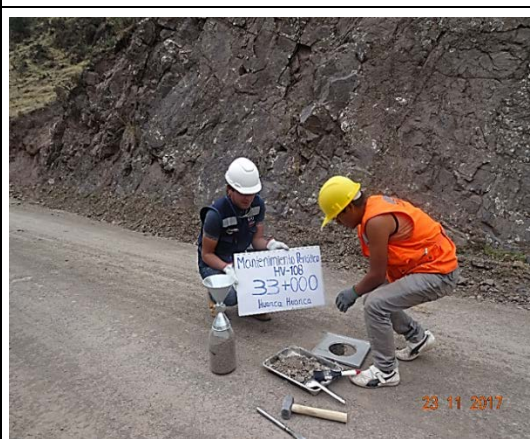
VERIFICACIÓN DE LA DENSIDAD DE AFIRMADO DE LA PLATAFORMA
