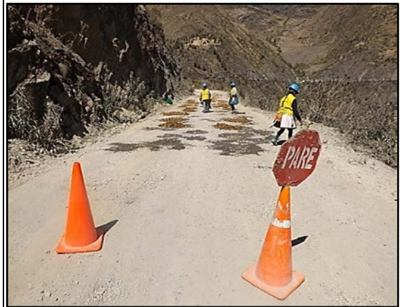
BACHEO DE LA PLATAFORMA
