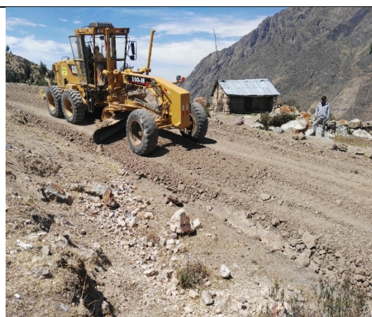
LASTRADO DE LA PLATAFORMA
