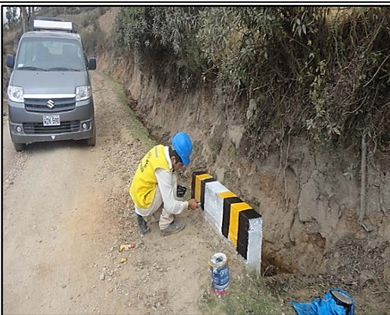
PINTADO DE CABEZAL DE ALCANTARILLAS
