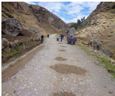
BACHEO DE LA PLAFORMA
