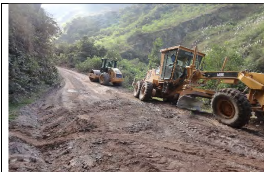
Trabajos de perfilado
