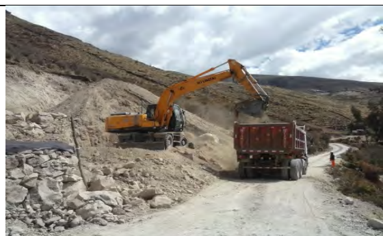
Carguio de material para el afirmado
