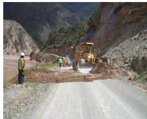
LIMPIEZA DE DERRUMBE
