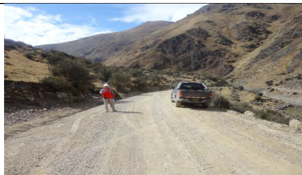
Trabajos de riego, perfilado y compactado
