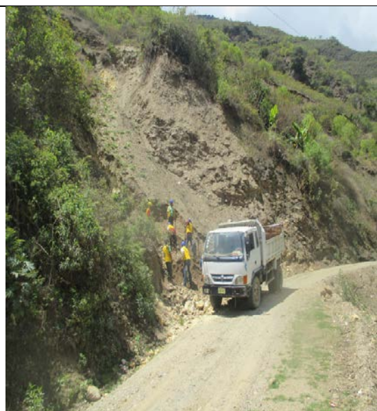
LIMPIEZA DE DERRUMBES MENORES
