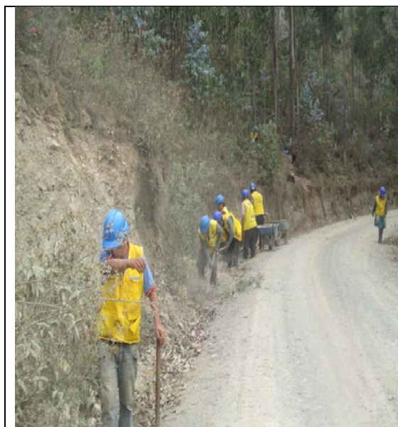
LIMPIEZA DE CUNETAS
